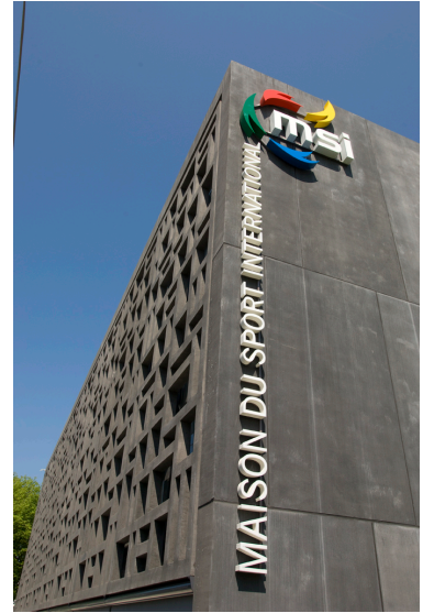
Maison du Sport International, Avenue de Rhodanie 54, 1007 Lausanne
